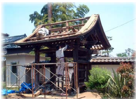
五月三十日から宮大工志賀建設が山門の解体工事を始めました。
