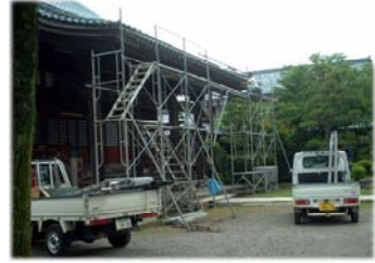
本堂前面の雨樋交換の様子。6/8
