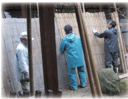
手分けして雪吊りと雪囲いの作業をして頂きました。竹を編んだ雪囲いは、設置が面倒ですが大変風情があります。
